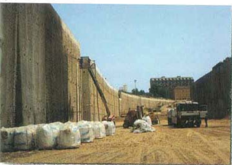
PASSANTE FERROVIARIO, SCALO FARINI, Milano
