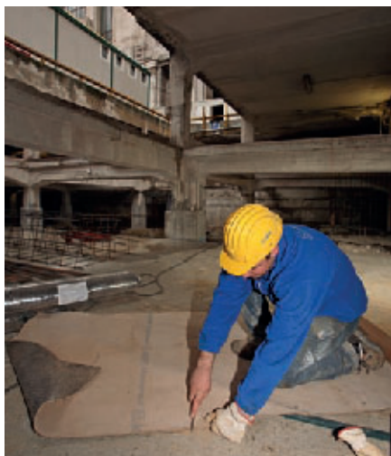
Preparazione del telo Mapeproof
