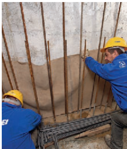
Stesura del telo Mapeproof
