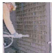
Applicazione a spruzzo della malta da ripristino
