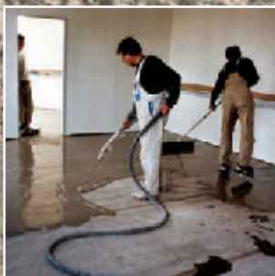
Applicazione di Ultraplan Eco con pompa
