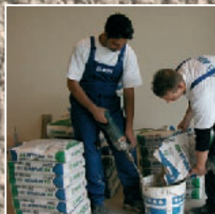
Miscelazione di Ultraplan Eco con acqua
