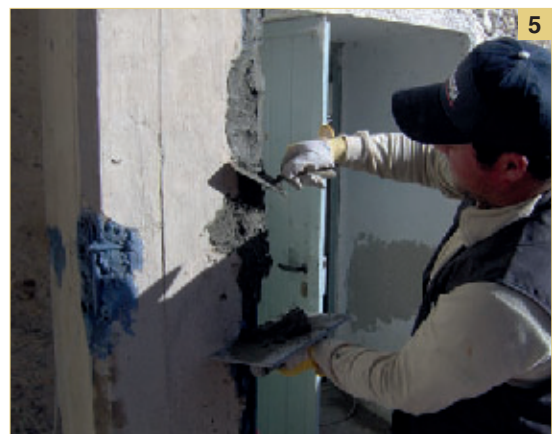
Foto 5. Le sezioni di calcestruzzo asportate sono state ricostruite a mano con Mapegrout Easy Flow GF. La malta è stata addizionata con Mapecure SRA per garantirne una corretta maturazione senza ritiri o microfessurazioni.
