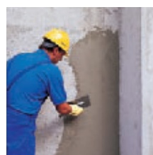
Fasi di ripristino e protezione impermeabilizzante del calcestruzzo
