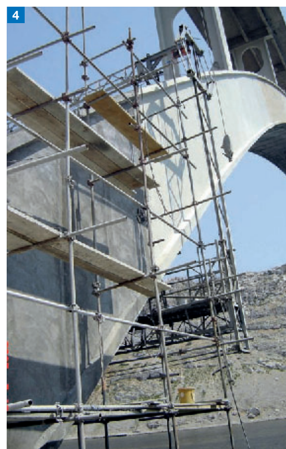
Foto 4. Fase di avanzamento lavori di finitura e protezione della struttura con il sistema Elastocolor.
