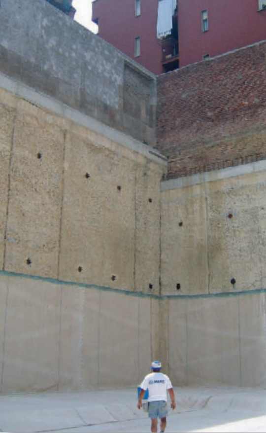
Impermeabilizzazione di struttura interrata contro diaframmi
