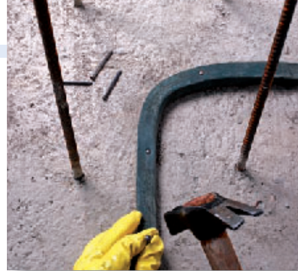
Particolare di applicazione del giunto bentonitico Idrostop B25
