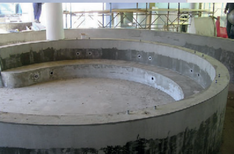
Sopra: la vasca interna prima della posa del rivestimento e in funzione a lavori conclusi.
