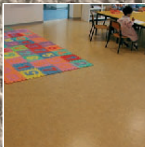
Linoleum applicato su massetto lisciato con Ultraplan Eco
