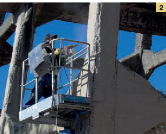
Foto 2 e 3. Il calcestruzzo in fase di distacco è stato rimosso meccanicamente.
