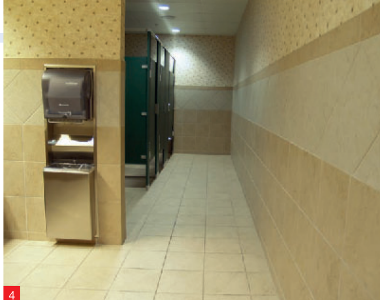
Foto 3. Le piastrelle ceramiche per i pavimenti del ristorante sono state posate con Ultraflex 2 e fugate con Keracolor S.
