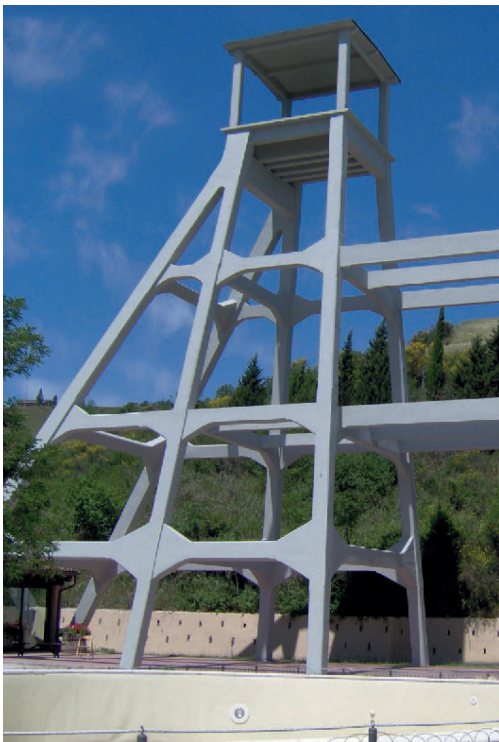
Foto 5. Le sezioni di calcestruzzo asportate sono state ricostruite a mano con Mapegrout Easy Flow GF. La malta è stata addizionata con Mapecure SRA per garantirne una corretta maturazione senza ritiri o microfessurazioni.
