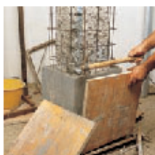
Ripristino strutturale con malta colabile monocomponente ad alte prestazioni meccaniche
