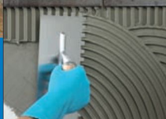
Stesura di Ultralite S1 con spatola dentata
