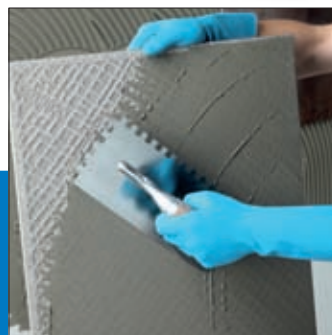
Stesura dell'adesivo sul retro della piastrella
