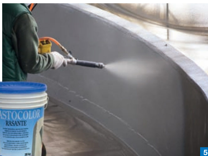
Foto 5. 2008: applicazione di Elastocolor Rasante a spruzzo.
