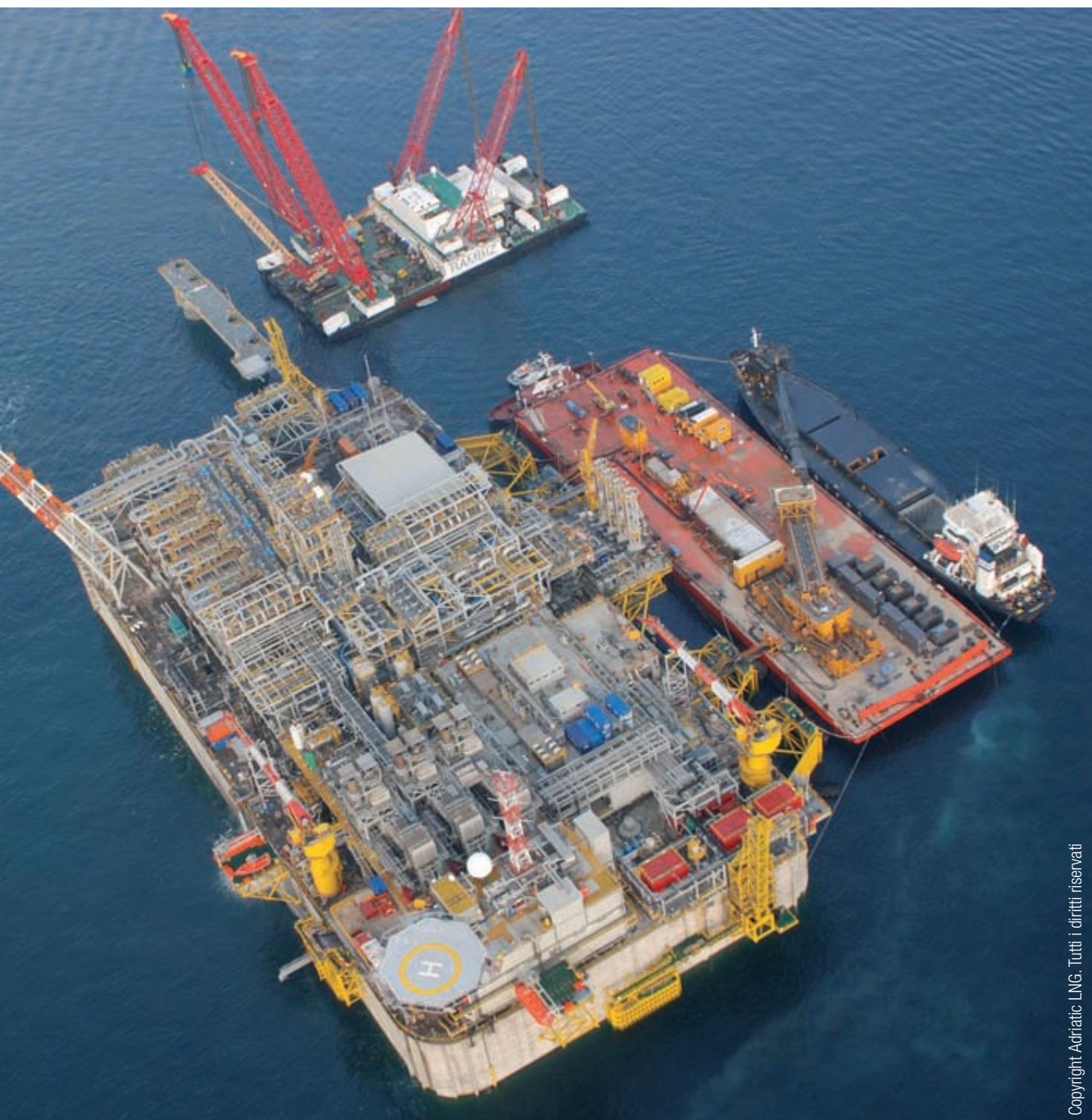
Foto 12. Veduta aerea del rigassificatore giunto a destinazione davanti alle coste di Rovigo.
