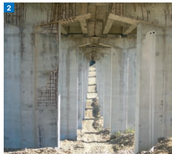
Foto 2 e 3. Travi, pile e baggioli del viadotto presentavano distacchi localizzati e dilavamento del calcestruzzo con la messa a nudo dei ferri di armatura. Per la ricostruzione del calcestruzzo asportato è stata utilizzata la malta MAPEGROUT EASY FLOW GF.
