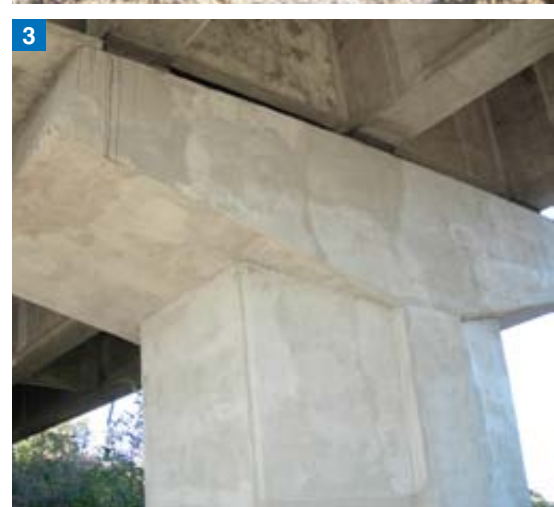
Foto 4. La protezione finale è stata effettuata con ELASTOCOLOR PRIMER ed ELASTOCOLOR PITTURA.
