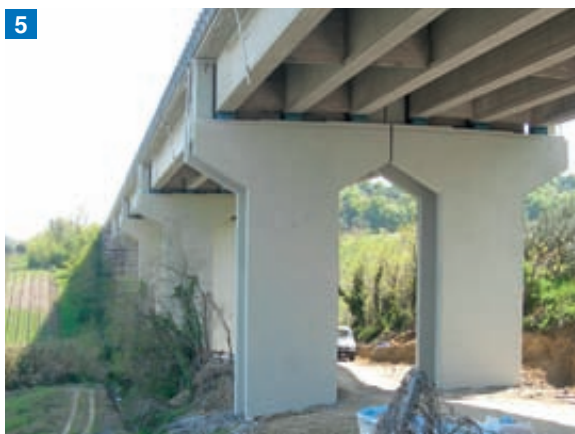
Foto 5. Al termine dell'intervento, per la protezione delle superfici ripristinate è stato eseguito un ciclo di finitura con ELASTOCOLOR PRIMER ed ELASTOCOLOR PITTURA.
