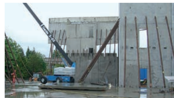
Lo stabilimento di Vancouver e i recenti lavori di ampliamento che lo stanno interessando.
