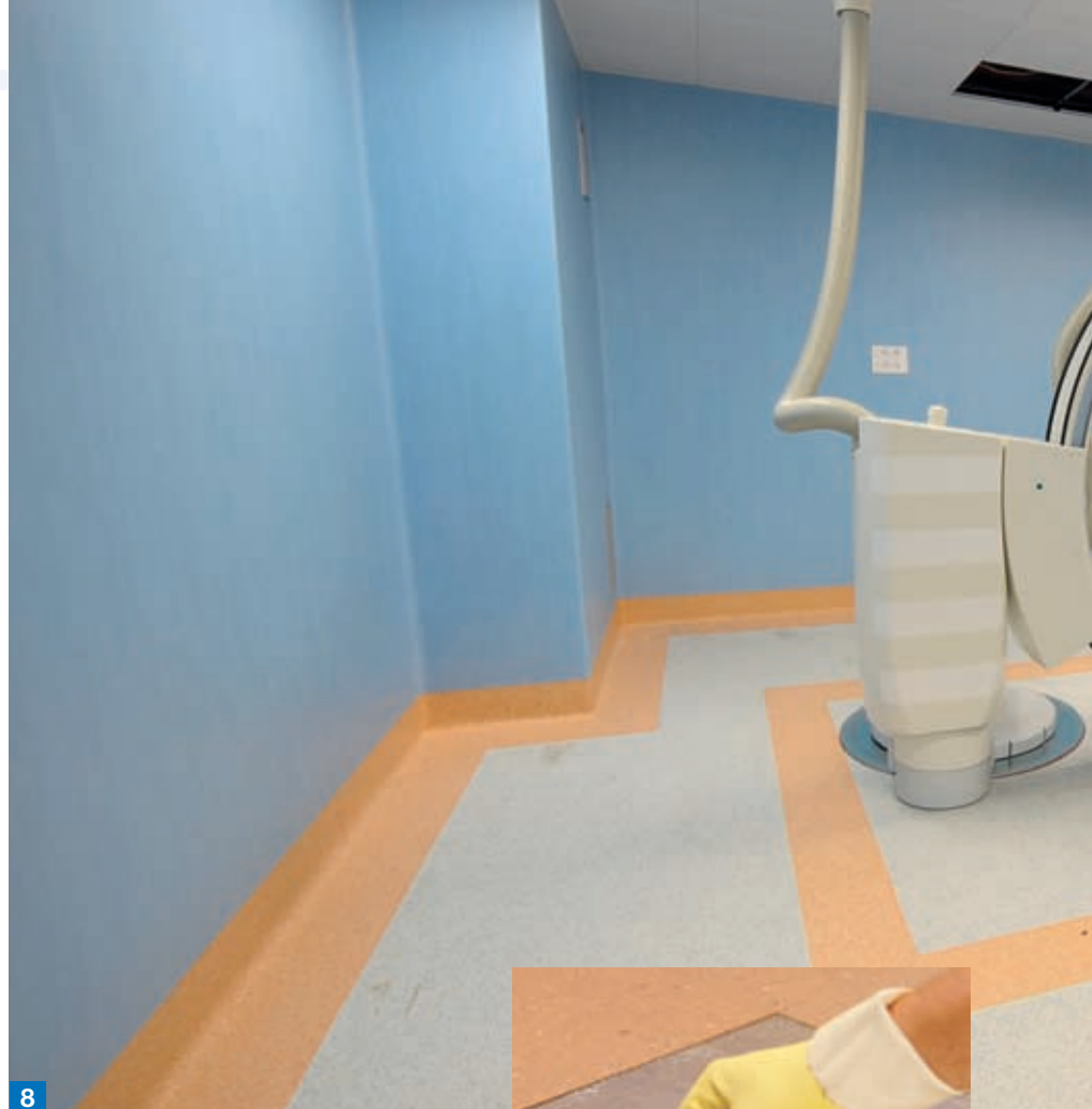
Foto 5. Dopo aver rimosso i vecchi pavimenti e aver rasato e livellato le superfici con NIVORAPID e PIANOCEM MEDIO, sui pavimenti del reparto di Pronto Soccorso sono stati posati i teli in gomma con l'adesivo ULTRABOND ECO V4 SP.
