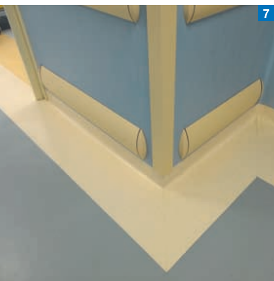
Foto 6. Le pareti divisorie del Pronto Soccorso, realizzate in cartongesso e preventivamente trattate con PRIMER G, sono state rivestite con teli in PVC incollato con ULTRABOND ECO V4 SP.
