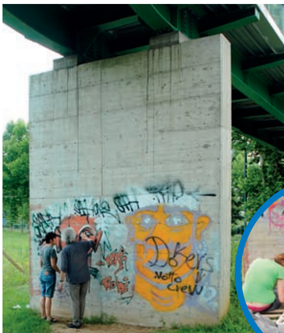
A destra: un pilastro prima dell'inizio del lavoro. Un luogo anonimo ed in parte abbandonato.
