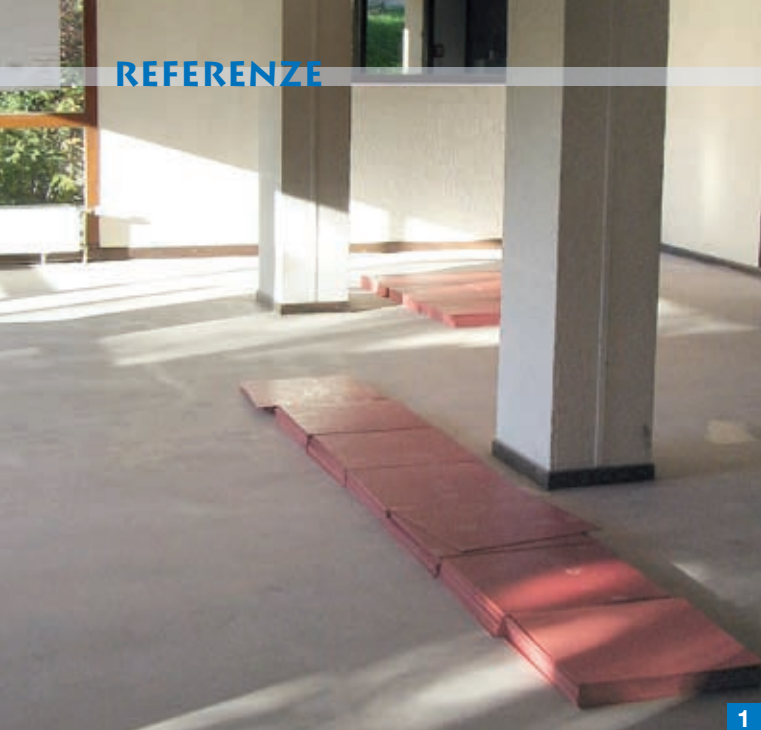
Foto 1. Il pavimento del refettorio prima della posa del rivestimento in gomma.
