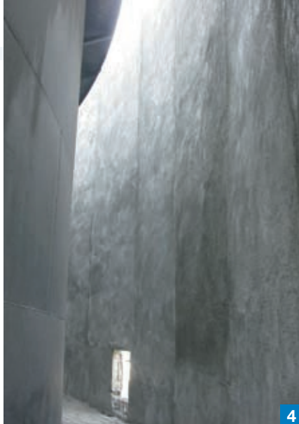
Foto 4. L'interno del contenitore presentava spazi ristretti e poca ventilazione e i tecnici hanno quindi consigliato di applicare MAPEGROUT GUNITE per via umida.
