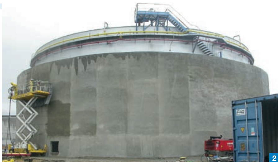
Foto 1. Prima dell'applicazione di MAPEGROUT GUNITE, la vasca di protezione in calcestruzzo è stata pulita da polvere e parti non aderenti.
