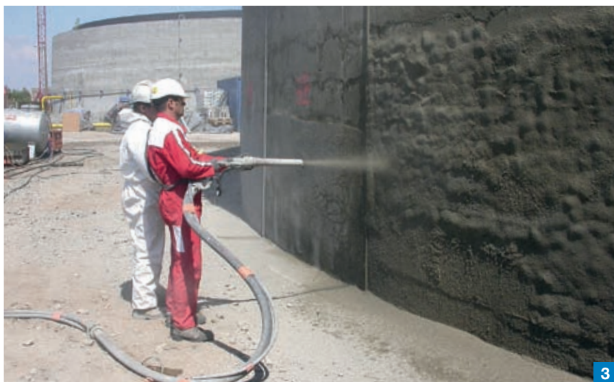
Foto 2 e 3. Sul lato esterno del contenitore MAPEGROUT GUNITE è stata applicata per via secca e, per rimediare all'essiccazione troppo veloce causata dai venti atlantici, alla miscela da spruzzare è stato aggiunto l'additivo MAPECURE SRA 25.
