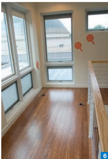
Foto 5 e 6. I pavimenti del secondo e del terzo piano sono stati rivestiti in legno di bambù posato con ULTRABOND 990.
