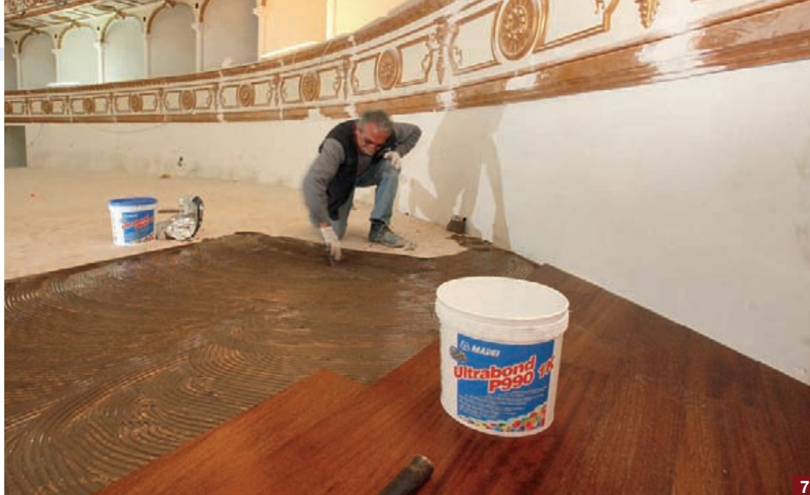
Foto 7. Il parquet (Iroko prefinito) dell'intera platea è stato posato con ULTRABOND P990 1K.
