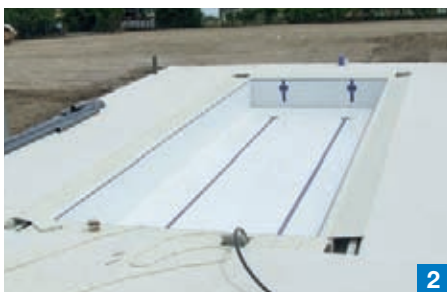
Foto 1. Le piscine sono state impermeabilizzate con la malta cementizia MAPELASTIC armata con la RETE IN FIBRA DI VETRO.
