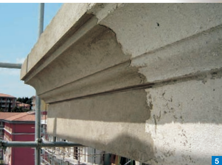
Foto 5. Stesura di PLANITOP 400 sulla cornice in calcestruzzo.
