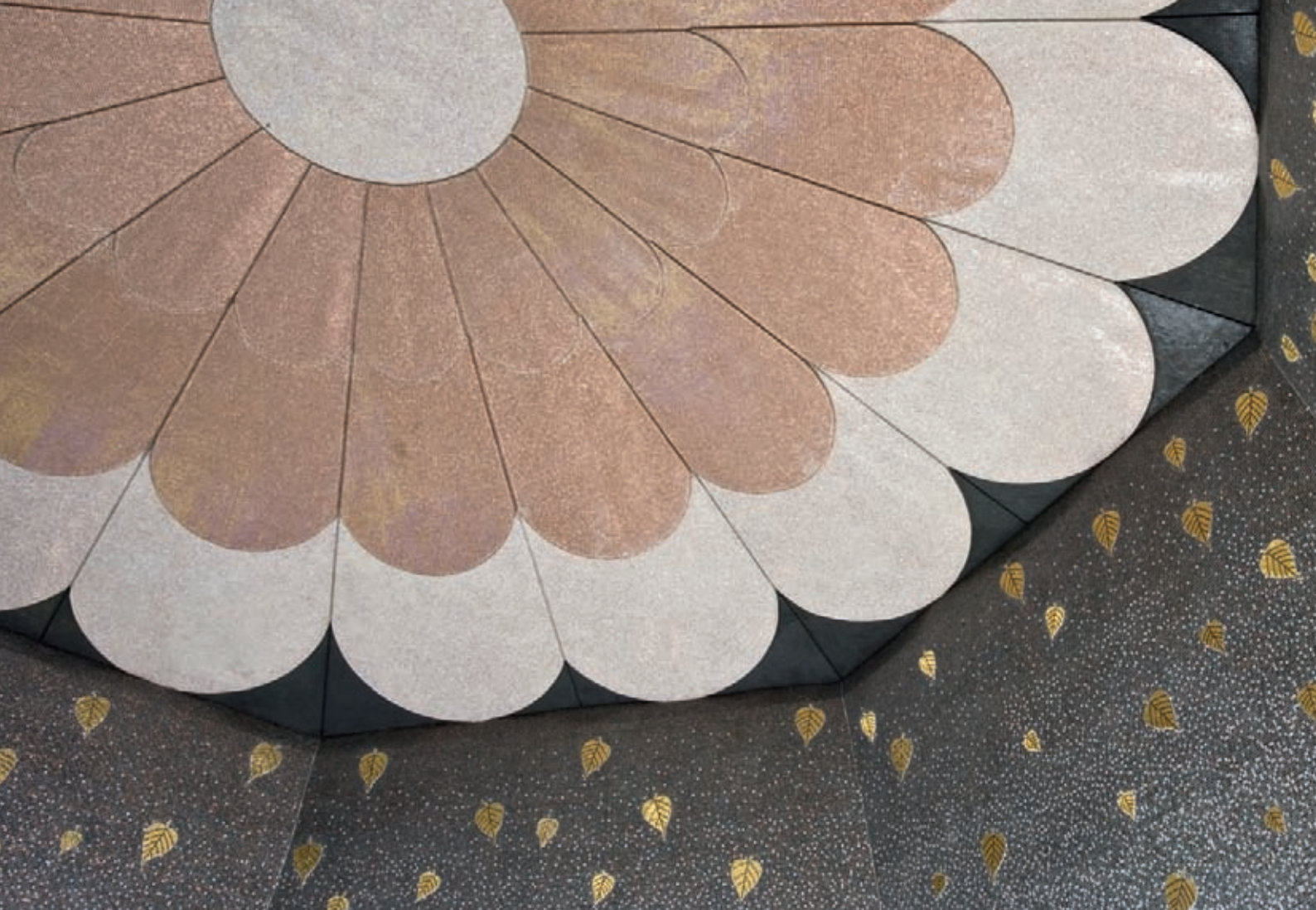
Foto 14. I mosaici sagomati a mano premontati con la forma di foglie di fico, che sono stati posati sulla superficie delle pareti interne.
