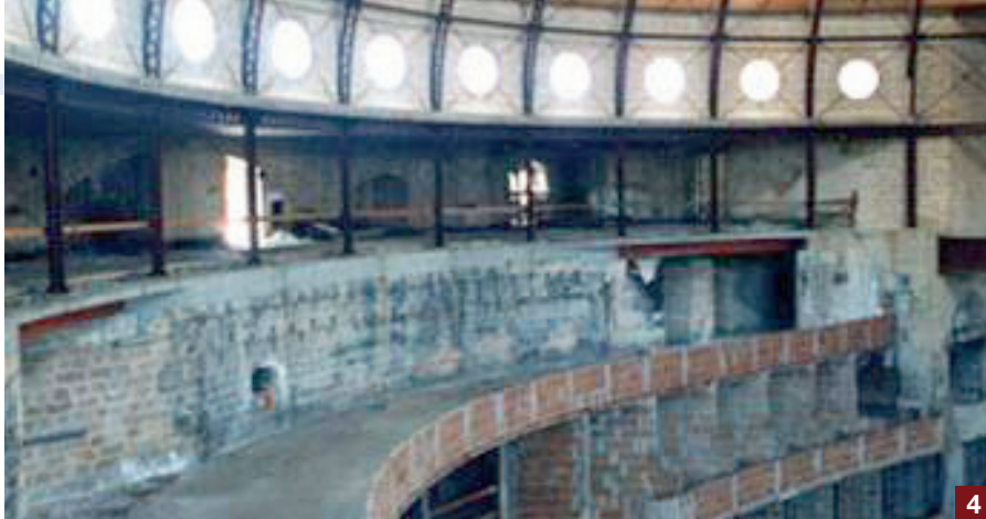
Foto 1. Oltre 6.000 m 2 di massetti in interno e in esterno, riscaldanti e non, sono stati posati con TOPCEM e TOPCEM PRONTO.
