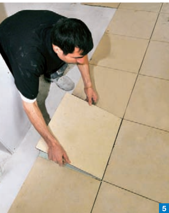
Foto 5. Alcuni pavimenti in ceramica del sesto piano sono stati posati con l'adesivo KERAFLUID SCA.
