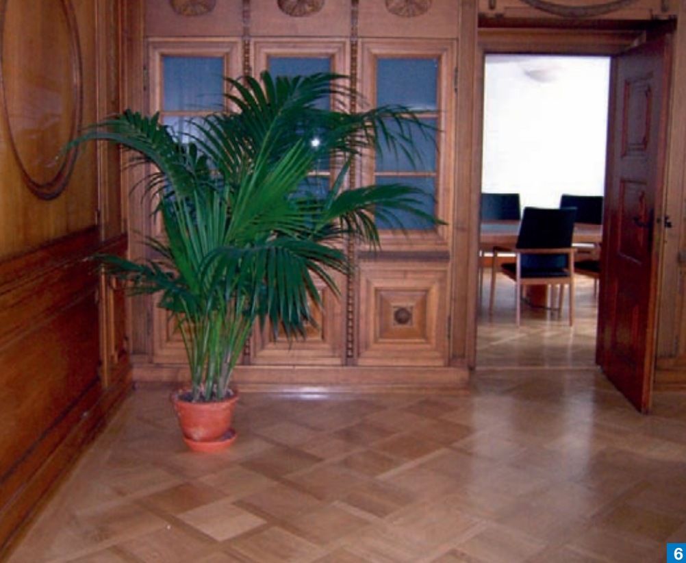
Foto 6. Un'immagine dei pavimenti in legno alla fine dei lavori.
