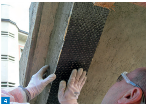
Foto 3. La scala di accesso e i pilastri che sorreggono la passerella sono stati riparati e rinforzati con MAPEWRAP SYSTEM.
