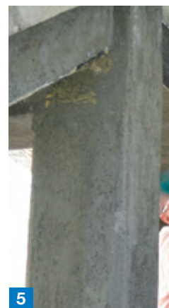
Foto 3. La scala di accesso e i pilastri che sorreggono la passerella sono stati riparati e rinforzati con MAPEWRAP SYSTEM.
