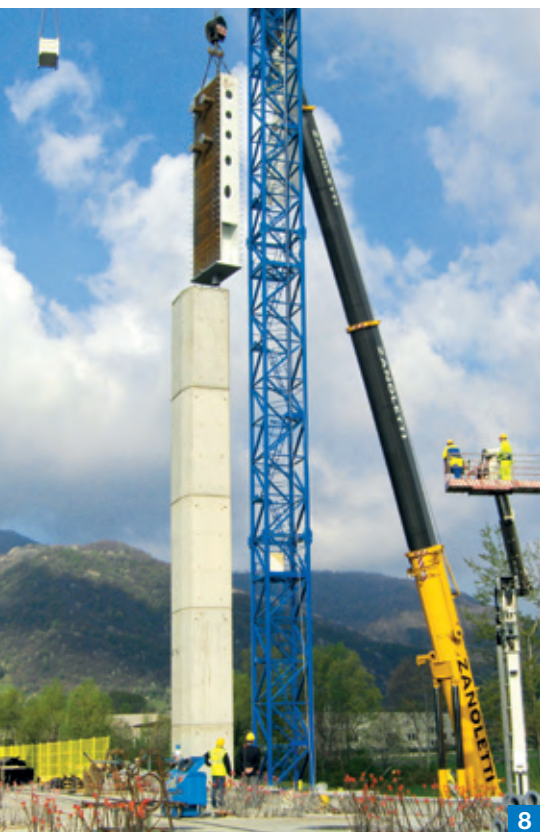
Foto 8. Il posizionamento dei quattro "scatolari metallici" in sommità ai fusti delle antenne con la funzione di aggancio degli stralli a sostegno dell'impalcato.
