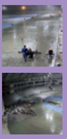
Palazzo del ghiaccio Minsk - Bielorussia Pavimentazione in calcestruzzo senza giunti realizzata da S. NORD PAVI 2000 con MAPECURE SRA 25, EXPANCRETE
