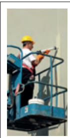
Capannone Industriale Milano - Italia Sigillatura dei giunti di facciata in calcestruzzo prefabbricato con MAPEFLEX PU 40
