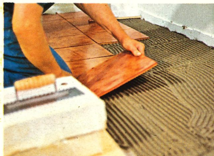
Posa con KERAFLOOR di bicottura 30x30 con spessore di adesivo 6 mm. ca.
