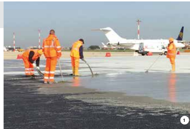
1. Posa in opera di MAPEGROUT DRAIN FILL NV per l'intasamento dei vuoti del conglomerato bituminoso open grade. 2. Operazioni di finitura superficiale.
