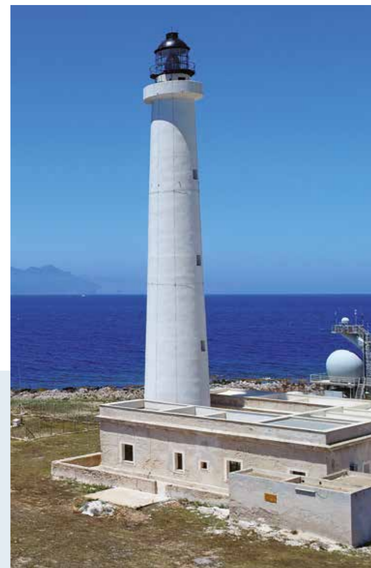
Faro Punta Sottile, Favignana. Tra gli interventi realizzati per la ristrutturazione del faro di Punta Sottile, a Favignana, ci sono stati anche il recupero e il risanamento delle murature mediante l'utilizzo di prodotti specifici come MAPE-ANTIQUE ALLETTAMENTO, MAPE-ANTIQUE RINZAFFO, MAPE-ANTIQUE MC MACCHINA.
