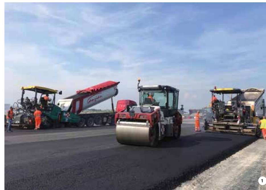
1. Realizzazione strato di Base ad elevate prestazioni nella pista secondaria, mediante l'impiego di MAPEI ACF-L2/ MAPEPLAST PAVI 02. 2. Stesa strato di Binder ad elevate prestazioni nel Raccordo A, mediante l'impiego di MAPEI ACF-L2/ MAPEPLAST PAVI 02.
