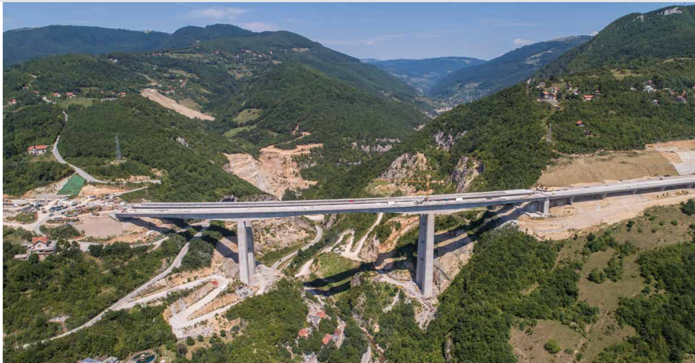
A SINISTRA. Il viadotto di Babina Rijeka, presso Zenica.
