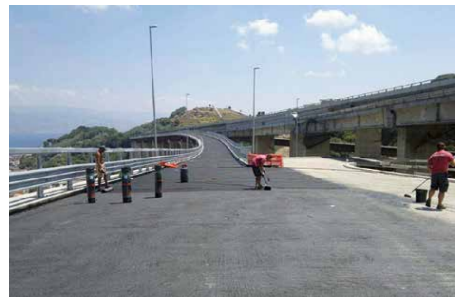
Preparazione del piano di posa con Primer per membrana bituminosa. Utilizzare membrane bituminose in un pacchetto stradale permette di aumentare portanza e vita utile, riducendo drasticamente i costi di manutenzione.
