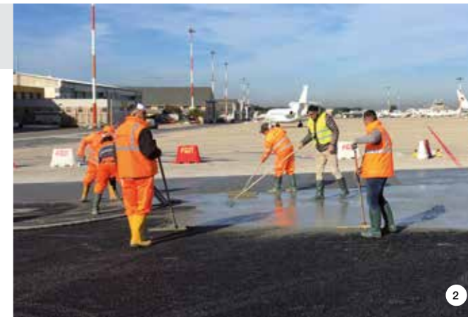
1. Posa in opera di MAPEGROUT DRAIN FILL NV per l'intasamento dei vuoti del conglomerato bituminoso open grade. 2. Operazioni di finitura superficiale.
