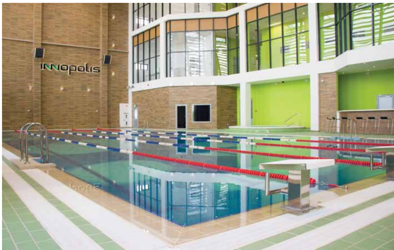
La piscina è stata impermeabilizzata con MAPELASTIC e le piastrelle sono state posate con KERACRETE + KERACRETE POLVERE.
