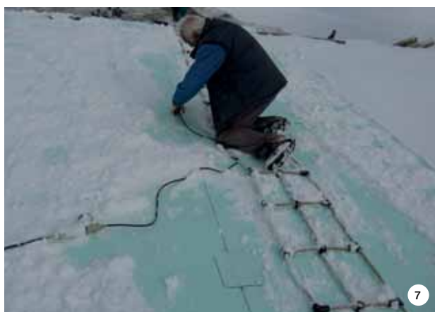
FOTO 5 e 6. Lavori di posa del manto MAPEPLAN T WT sulle sponde e sul fondo del bacino.
