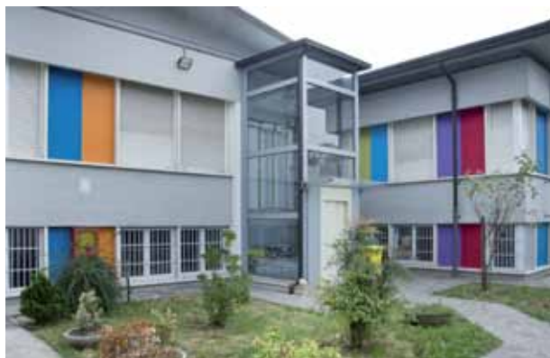
Un'immagine di CasArché, per la cui costruzione Mapei ha fornito numerosi prodotti per la realizzazione dei massetti, l'impermeabilizzazione, la posa di ceramica e le finiture.
