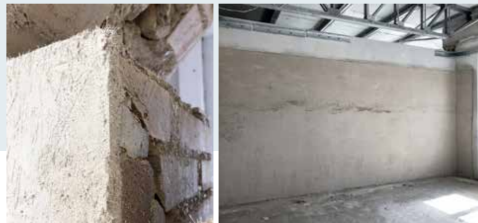
Primo piano sul prodotto applicato e vista del pannello murario a seguito del rinforzo.
