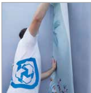
5 Dekoratív üvegszövet fektetése Laying of decorative fiberglass
