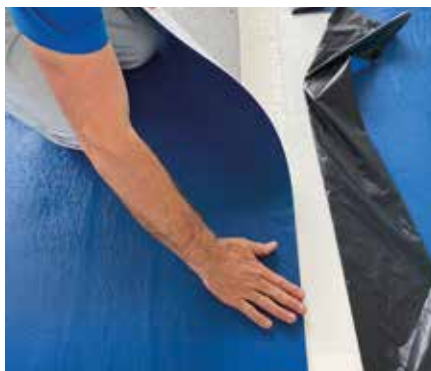
Hosszirányú átfedések a tekercsek között.
