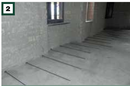
Kihorgonyzás a szélek körül betonacélokkal
