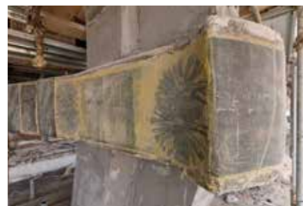
Kötőgerenda megerősítve FRP rendszer technológiával. Tie-rod strengthened with FRP System technology.
