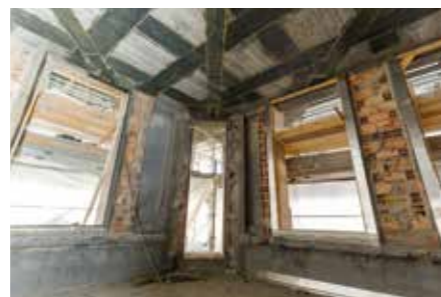
Egy földem hajlítási megerősítése FRP rendszerrel. Flexural strengthening of a floor slab with FRP System.
