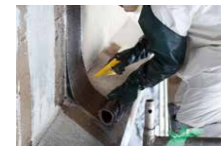
A szénszálás szövet alkalmazása. Application of carbon fibre fabric.
