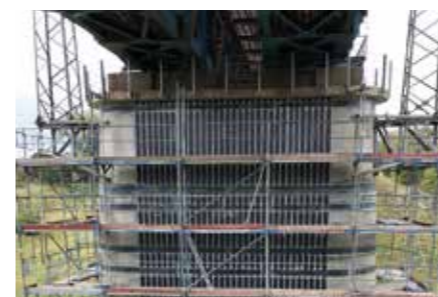
Szerkezetmegerősítés karbonlemezekkel és szövetekkel.
