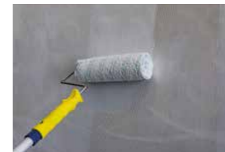
Poliuretán diszperziós ragasztó alkalmazása. Application of adhesive in polyurethane dispersion.
