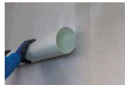
Kétirányú üvegszálal szövet alkalmazása. Application of bi-directional glass fibre fabric.
