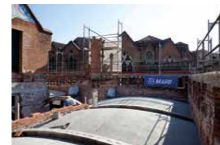
Az FRCM technológia alkalmazása a boltozatokon. Application of FRCM System technology on the vaults.
