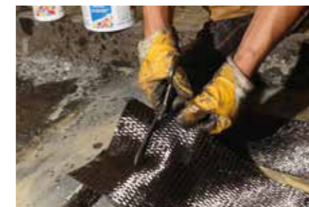
Szénzálal szövet méretre vágása a helyszínen. Cutting carbon fibre fabric to size on site.
