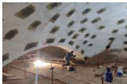
A boltívek és boltozatok belső oldalainak megerősítése.
