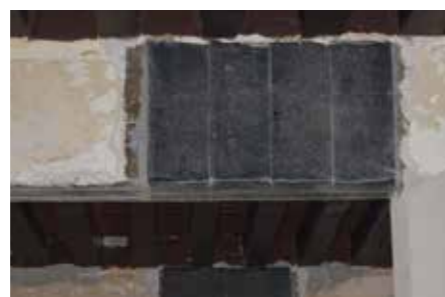
Szén-szálalamin szövetekkel megerősített gerendák. Beams strengthened with carbon fibre fabric.
