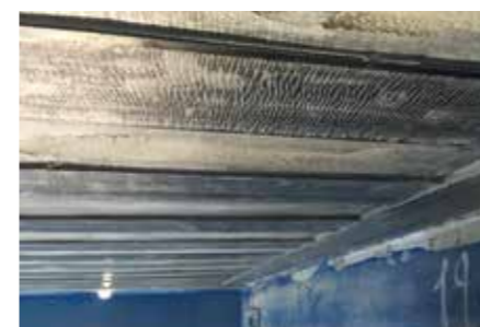
Pultrudált szénzálalás lemezek alkalmazása. Application of pultruded carbon fibre plates.
