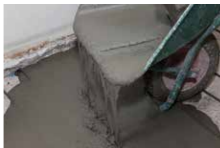
Planitop HPC-vel megerősített födémekek. Slabs strengthening with Planitop HPC Floor.
