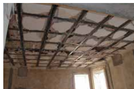
Szén-szálalaminokkal megerősített födém. Floor slab strengthened with carbon fibre plates.
