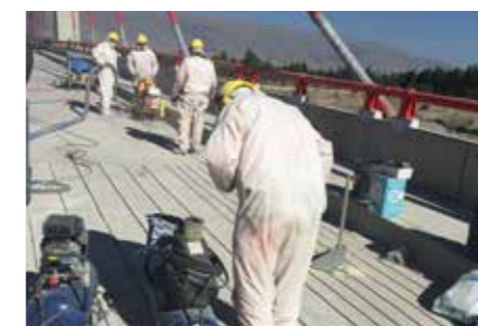
A pultrudált szénzálalás rudak alkalmazása. Application of pultruded carbon fibre rods.
