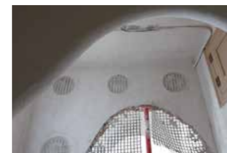
Belső falazat megerősítése FRM rendszerrel és FRP Fiocco zsinórokkal.
