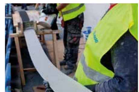
Epoxigyanta felhordása a szénzálalás lemezre. Application of epoxy resin on a carbon fibre plate.
