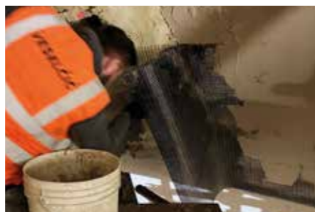
Az üvegszál háló alkalmazása.
