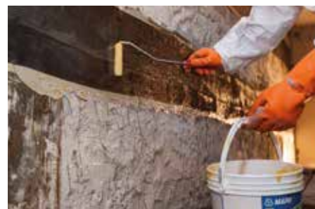
Vasbeton falak megerősítése FRP rendszerrel. RC shear wall strengthening.
