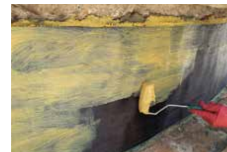
A tixotróp epoxiragasztó alkalmazása.
