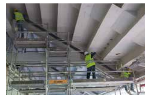
Szénzálalás lamellák felhelyezése a gerendákra. Installation of carbon fibre plates on beams.
