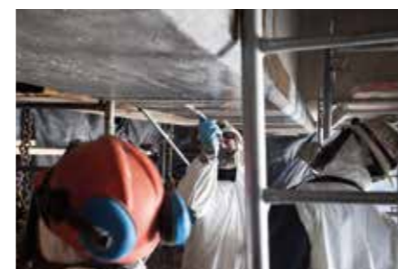
Epoxigyanták alkalmazása. Application of epoxy resins.
