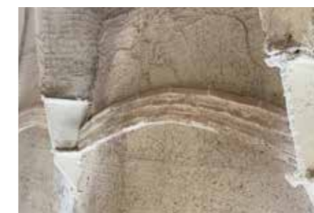
Megerősítés FRM rendszerrel a lépcsőtartó falazathoz.
