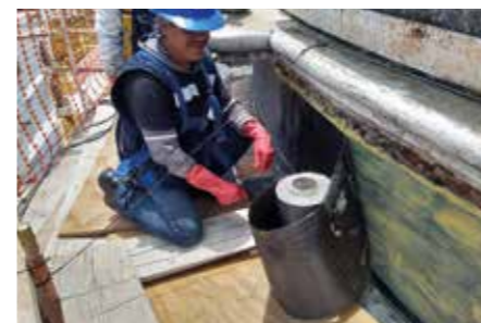
A szénsszál szövet alkalmazása.
