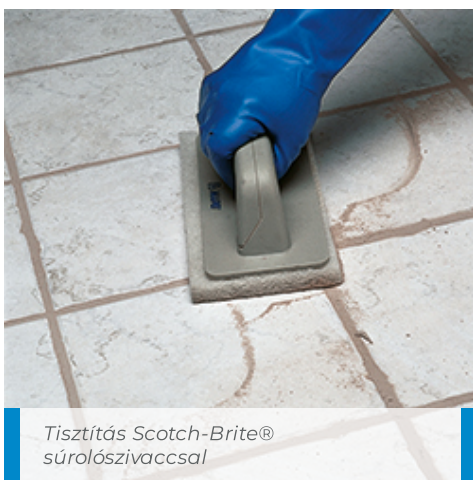
Üvegmozaik tisztítása szivaccsal
