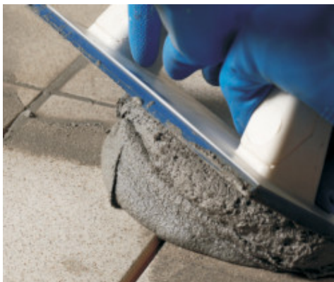
Padlóburkolat fugázása gumisimítóval
