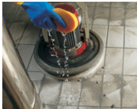
A Kerapoxy P letisztítása Scotch-Brite® súrolófilc-koronggal ellátott egyfejes csempetisztító-géppel
