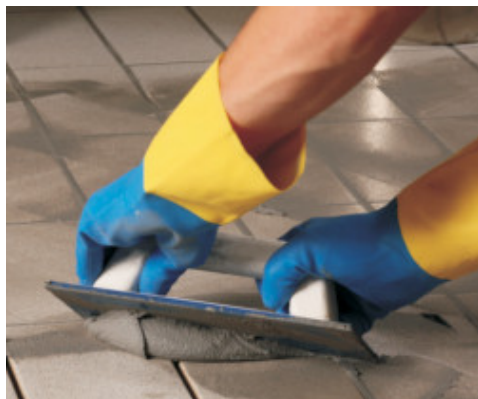
Padlóburkolat fugázása gumisimítóval
