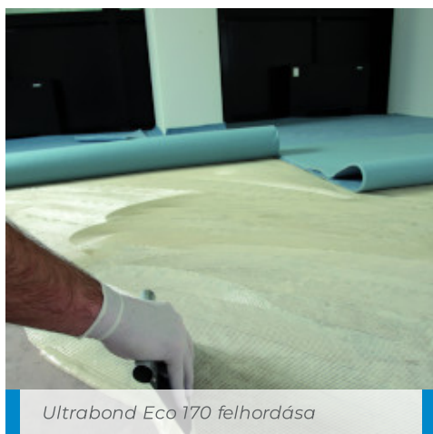
Padlószőnyeg burkolat fektetése
