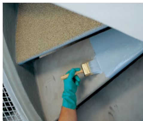
Az első réteg Mapecoat I 24 felhordása betonra
