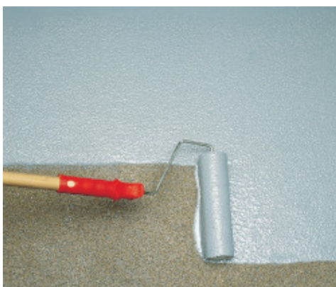
A Mapecoat I 24 felhordása hengerrel
