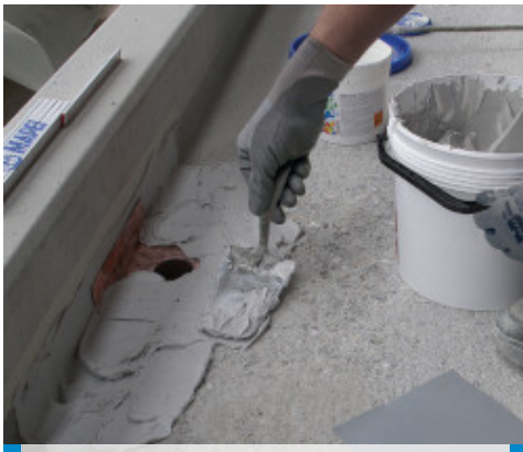
A következő Adesilex PG4 simítás felhordása
