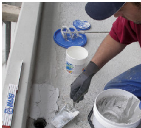
Adesilex PG4 felhordása simítóval
