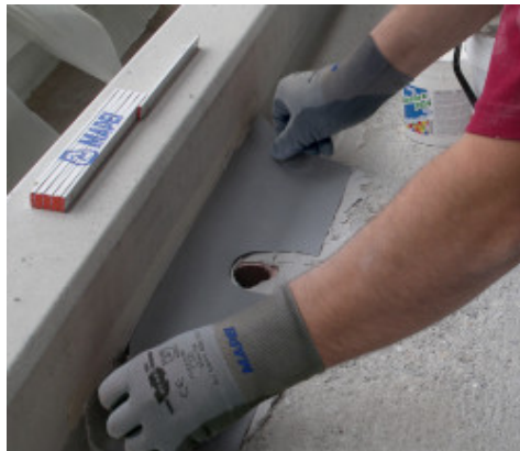
Rugalmas hypalon merevítő fektetése
