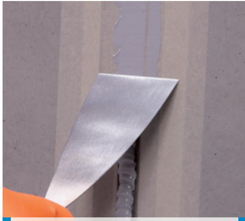
Mapeflex PU40átsimítása
