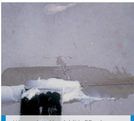
Hézag glettelése Additix PE-vel adalékolt Primer MF-fel
