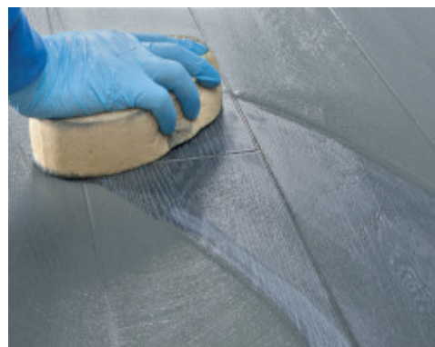
A fugahézagok tisztítása és felületképzése kemény cellulóz szivaccsal
