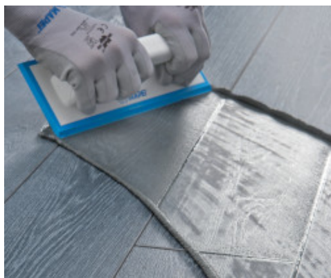
Ultracolor Plus terítése fa hatású gres padlóburkolaton gumisimítóval
