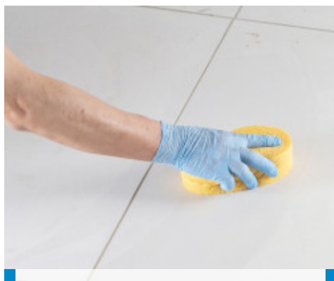
Fugahézagok tisztítása és felületképzése kemény cellulóz szivaccsal
