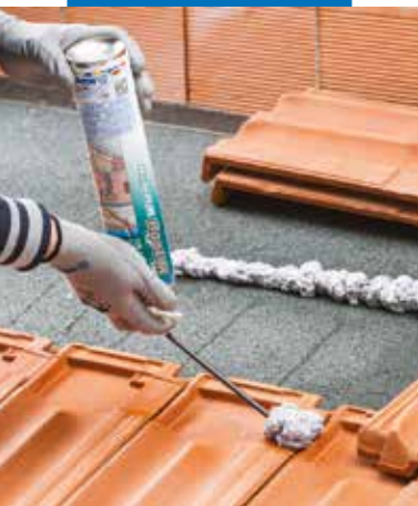
Tetőcserepek ragasztása foltokban alkalmazott termékkel
