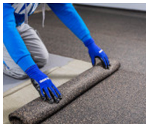
Tekerje ki a Mapesonic CR-t a szigetelendő felületre
