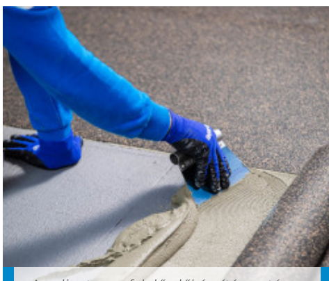
Az aljzat megfelelő előkészítése után terítse el a ragasztót a hangszigetelő lemez leragasztásához
