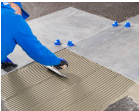
Az aljzat megfelelő előkészítése után terítse el a ragasztót a hangszigetelő lemez leragasztásához
