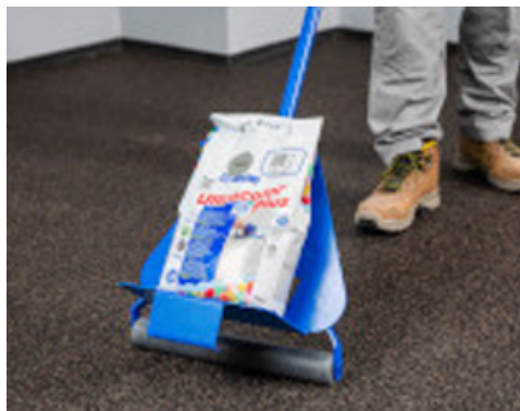
Simítsa le a felületet kemény hengerrel vagy simítóval, középtől kezdve és a szélek felé haladva
