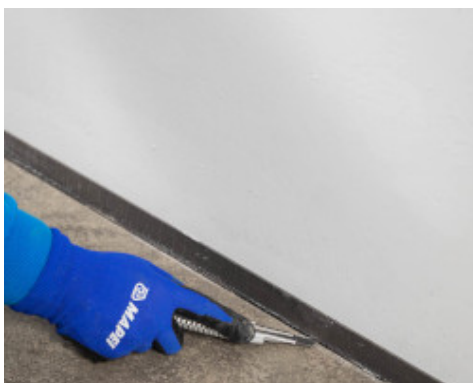
Ha a fugázó megkötött, vágja le a kerületi Mapesonic Strip-et a felesleg eltávolításához
