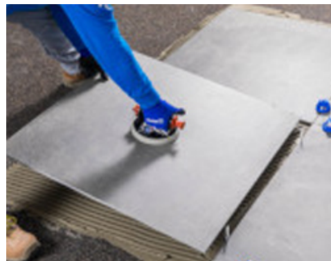
Terítse el a ragasztót a Mapesonic CR-re és ragassza le az új padlóburkolatot
