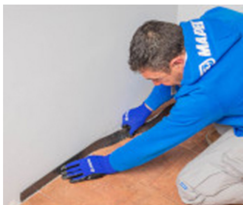
A Mapesonic Strip ragasztócsík beépítése a helyiség szélei mentén
