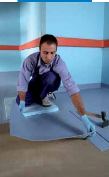
PVC padlóburkolat fektetése
