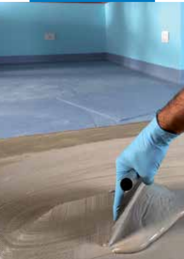
Az Ultrabond Eco 380 felhordása
