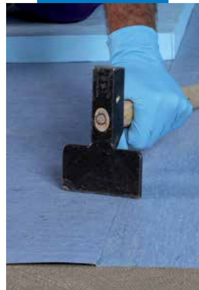
PVC lapburkolat simítása
