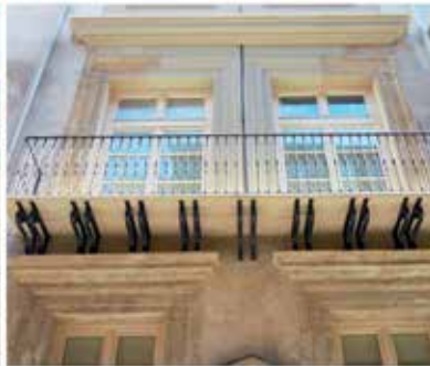
Az ablakok körüli díszítőelemek, a homlokzati tagozatok és párkányok rögzítését MAPETHERM AR1-gyel oldották meg.
