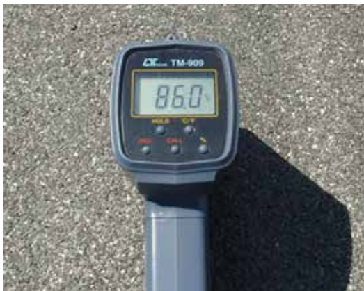
86 °C fokos felszíni hőmérséklet mérése egy szigeteléssel ellátott tető egy részén, amelyet nem ér berendezések tükröződő felületéről visszaverődő sugárzás
