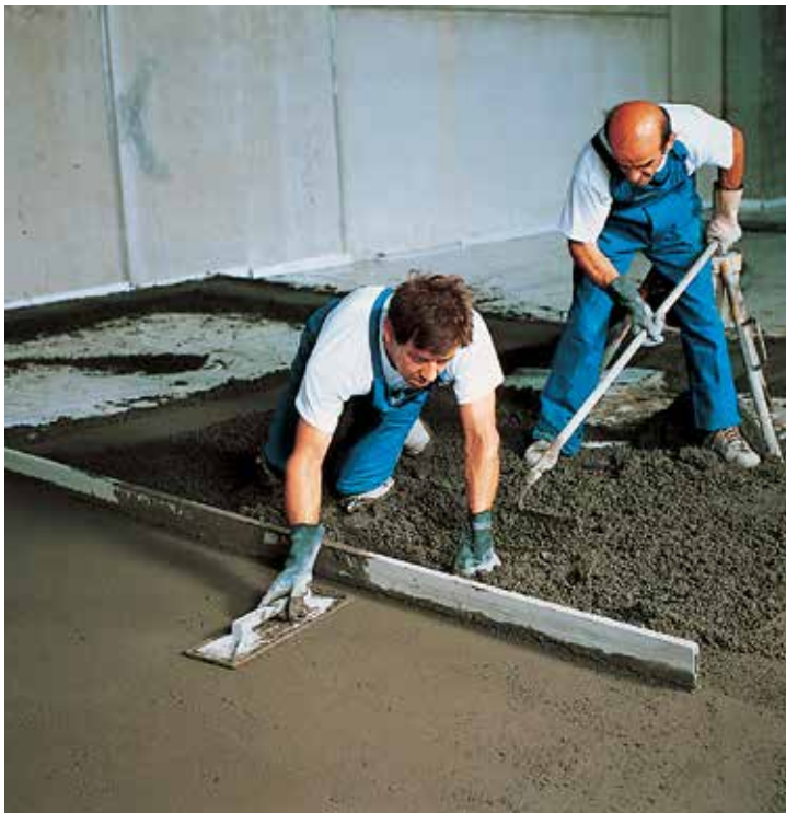
Az esztrich készítés során alkalmazható eszközök: öles lécs, kőműves kanál, esztrich kard, simító, esztrich pumpa
