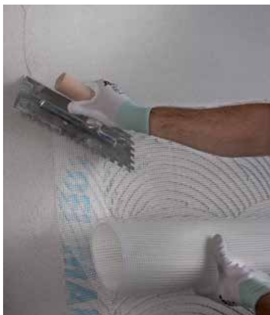
Üvegszövetháló helyes beágyazása: Az egyenletesen felvitt ragasztórétegre fektessük rá az üvegszövethálót és simítsuk át a felületet.
