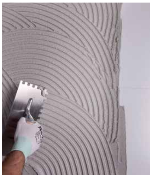
Üvegszövetháló helyes beágyazása: Vigyük fel a ragasztóanyagot 10-es fogazott glettvasal a hőszigetelő tábla felületére.
