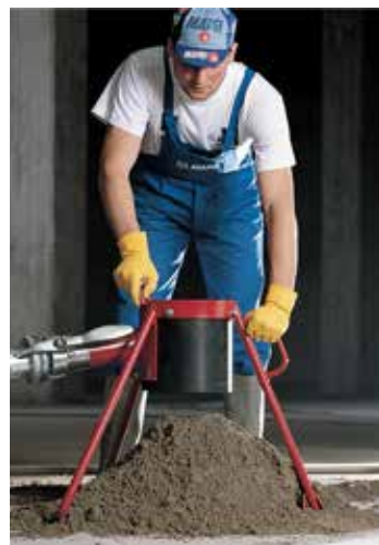
Az esztrich készítés során alkalmazható eszközök: öles lécs, kőműves kanál, esztrich kard, simító, esztrich pumpa
