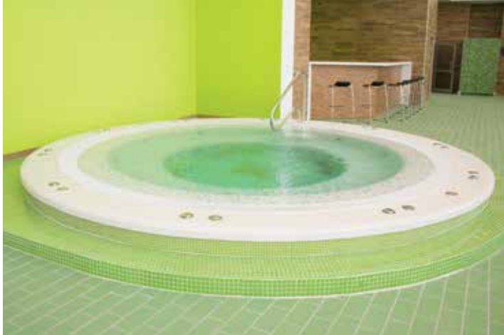
A medencék hajlatait és a csatlakozási hézagokat a rugalmas, és lúgálló MAPEBAND gumírozott szövetrel tették vízzáróvá.
