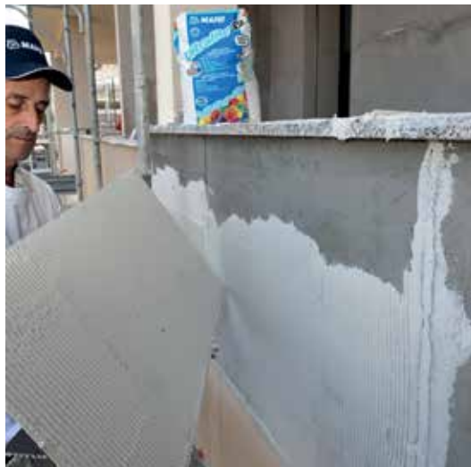
Burkolólap kétoldali ragasztása ULTRALITE S2-vel
