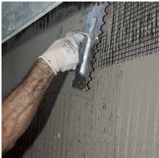
MAPEGRID G120 üvegszövetháló beágyazása a PLANITOP HDM MAXI szálerősített habarcsrétegbe
