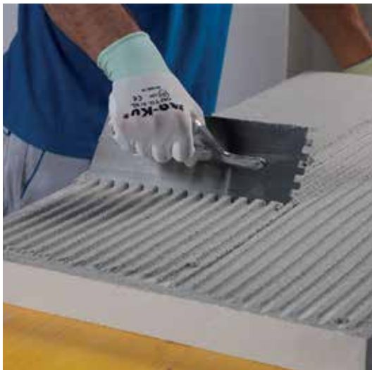
MAPETHERM AR1 GG felhordása teljes felületű ragasztáshoz
