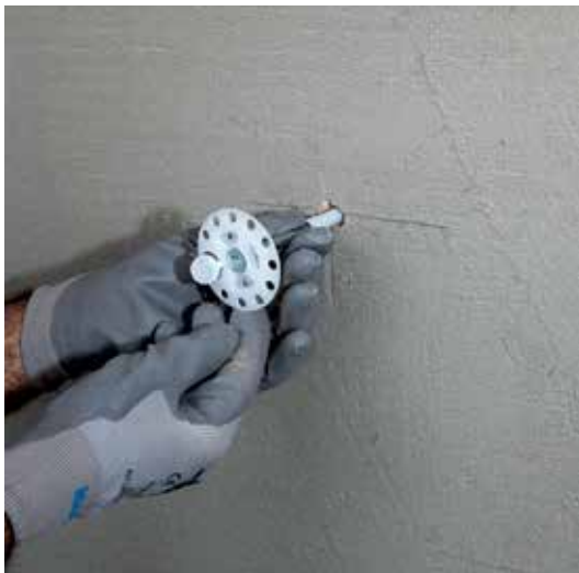
Mechanikai rögzítés MAPETHERM csavaros dübellel
