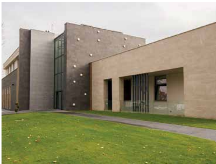
A Mapei MAPETHERM TILE SYSTEM megoldását alkalmazták Zalacsányban, az exkluzív szolgáltatást kínáló Zala Springs Golf Resort kivitelezése során.
