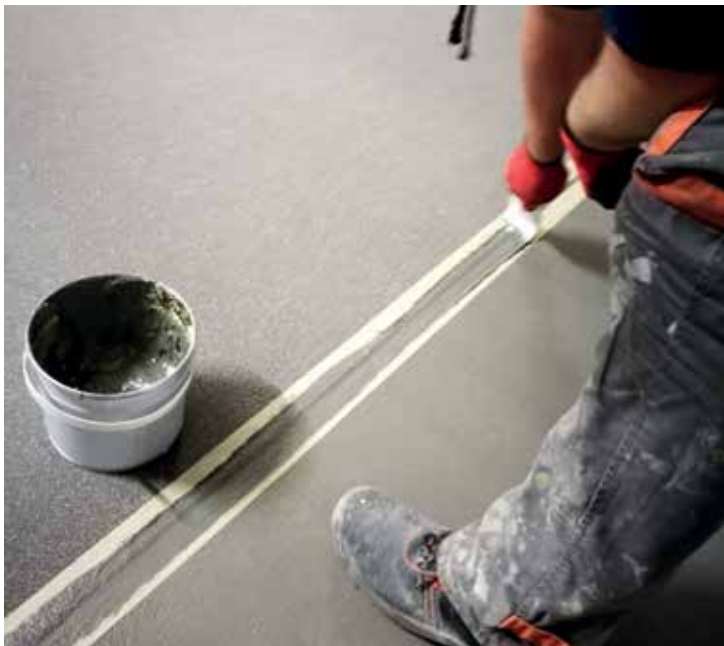
Dilatációs hézag felületének átfestése a tömitést követően MAPEFLOOR PU 400 LV-vel az egységes felület elérése érdekében. A dilatációs hézagok kialakításával tartósan biztosíthatjuk a felület repedésmentességét.
