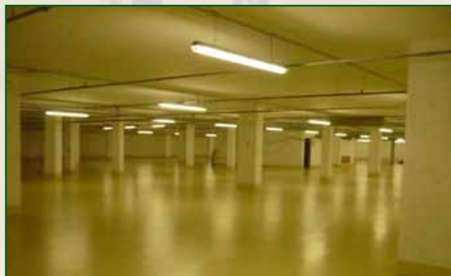
Az Uniqua Székház mélygarázs padlójának kialakításánál a választás a Mapei MAPEFLOOR SYSTEM 51-es rendszerére esett, RAL 1014-es színben.
