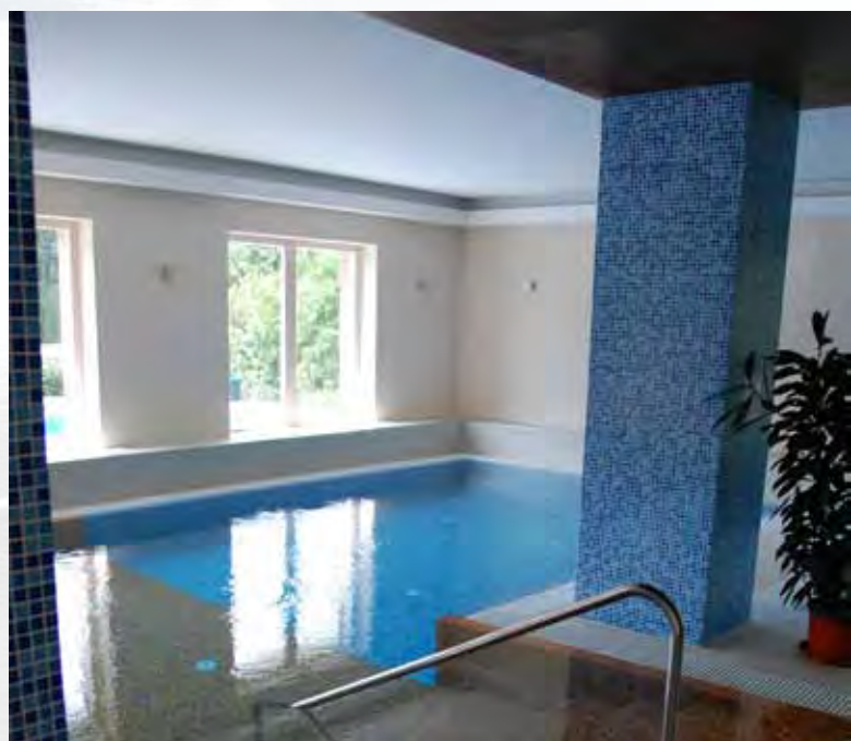
A medencék burkolását NIVOPLAN kiegyenlítés után a következő rétegrenddel végezték: PLANICRETE, MAPELASTIC, MAPEBAND, KERABOND és ISOLASTIC, ULTRACOLOR PLUS, MAPESIL AC.
