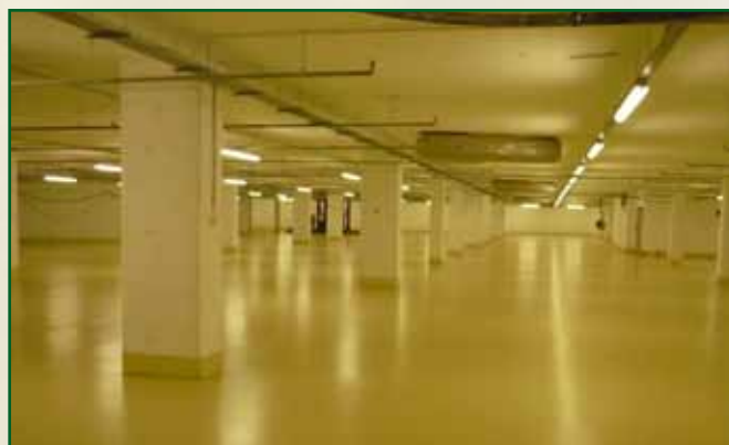
A végleges felületet egy MAPECOAT I 600 W fedőlakk bevonatot is kapott, ezzel növelve a kopásállóságot.
