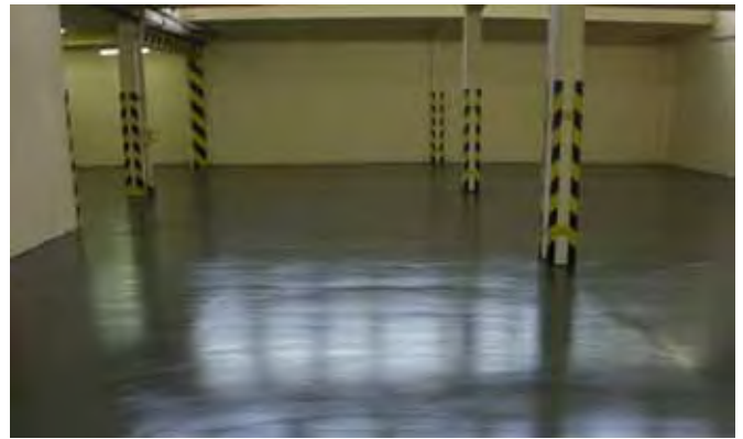
Raktárhelyiség cementkötésű ipari padlója
