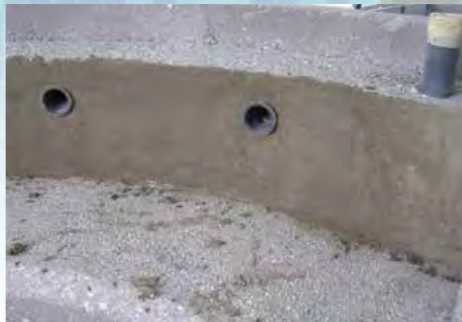
A jacuzzi kiegyenlítését a teljes felületen a PLANITOP 400 gyorskötésű, zsugorodás-kompenzált, állékony (tixotróp) javítóhabarccsal végezték.
