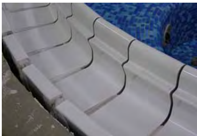
A változó szélességű fugahézag biztonságos és repedésmentes kitértésére a KERAPOXY fugázóanyag jelentett megoldást.
