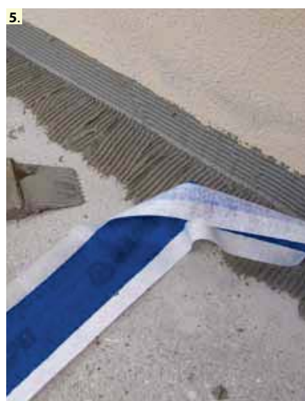
5. kép: A MAPEBAND termékcsalád elemeit a kenhető szigetelés első rétegébe ágyazzuk be.
