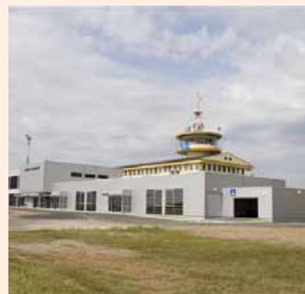
Airport Debrecen, hidegburkolati kivitelezés, 4000 m 2
