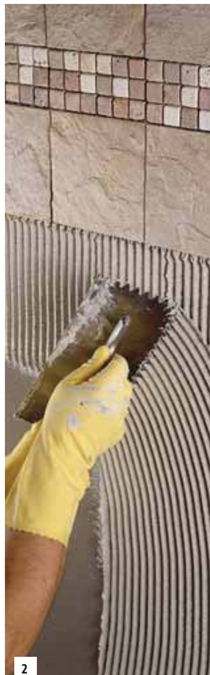
1., 2. kép Adesilex P9 felhordása
