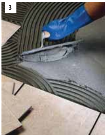
3., 4. kép Burkolólap ragasztása ADESILEX P9 ragasztóval
