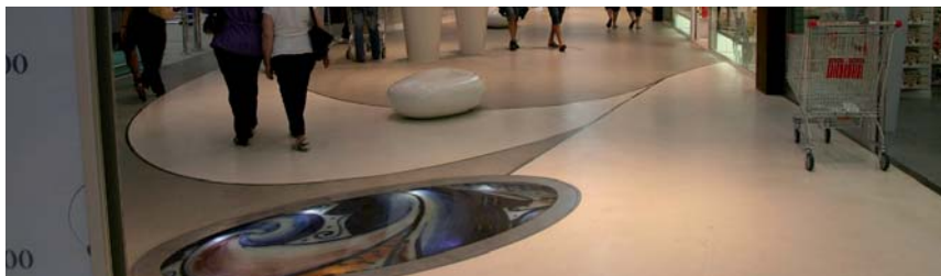
Kirekesztéssel készült felület két színben.
