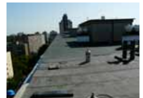
A PLANA P MINERÁL ráhelyezése a PLANA P rétegre
