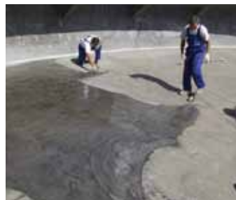
Alapozás MAPEFLOOR H02-vel. (2. fázis)
