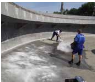
Kvarchomok hintés MAPEFLOOR H02 alapozás után (3. fázis)
