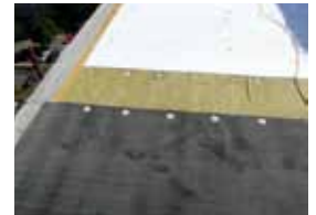
Hőszigetelés és a megkezdett vízszigetelés rétegei
