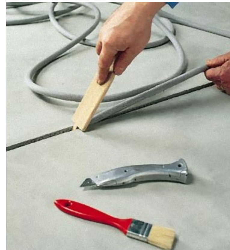
Dilatációs hézag mélyégének beállítása MAPEFOAM háttérzsinórral
