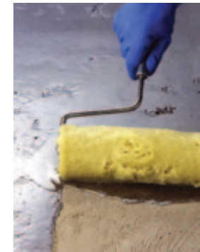
PRIMER MF párazáró alapozóval 4-5 CM% nedvességtartalomig burkolhatóvá tehetjük az aljzatot
