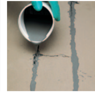
Aljzatunk repedéseit esztrichvarrással hozhatjuk rendbe. Ajánlott termék: EPORIP
