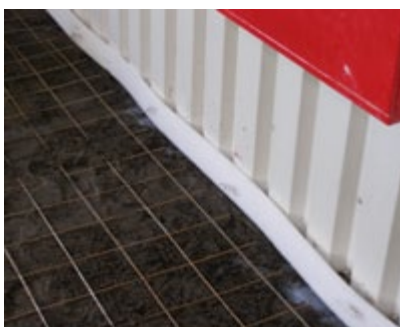
Szegélydilatáció kialakítása esztrich esetén
