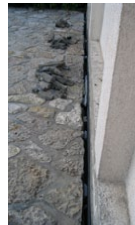
Szerkezeti dilatáció kialakításához alkalmazható speciális profil
