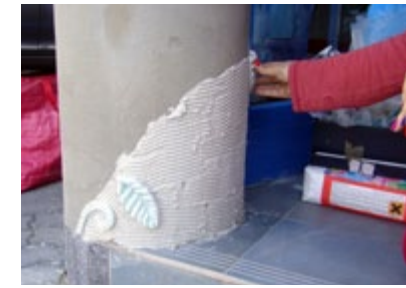
A mozaik elemeket KERABOND T és ISOLASTIC komponensekből álló, S osztályú paraméterekkel rendelkező ragasztóágyba fektették.
