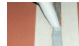
Dilatációs hézag kitöltése MAPEFLEX PU 55 SL rugalmas hézagkitöltővel
