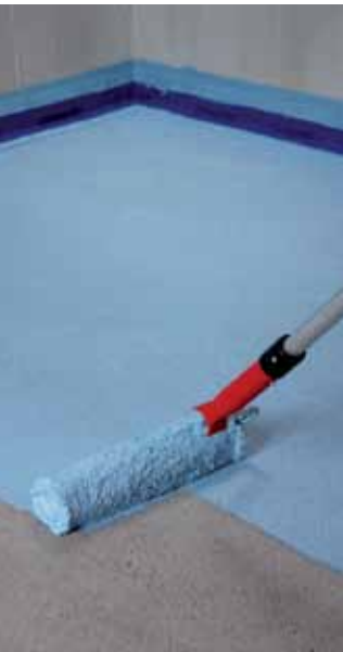
A könnyen kezelhető és gyors száradású MAPELASTIC AQUADEFENSE felhordása fürdőszoba padlójára
