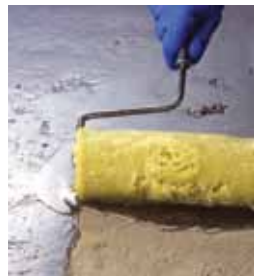
PRIMER MF és PRIMER SN párazáró alapozók segítségével bizonyos nedvességtartalomig megóvhatjuk rétegrendünket a bent maradt nedvességtől.
