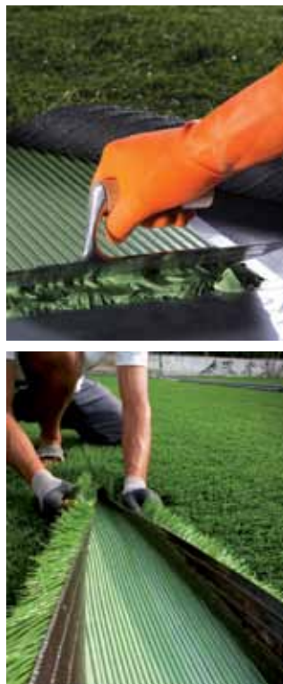
Az ULTRABOND TURF EP 2K-val általában csak a toldásoknál ragasztják össze a műfű burkolatot a műanyag illesztő szalagok segítségével.
