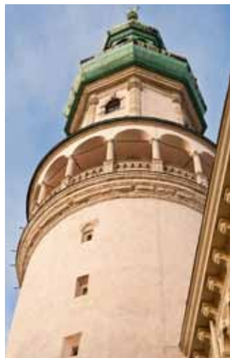
A homlokzaton alkalmazott MAPE-ANTIQUÉ rendszert speciálisan történelmi és műemlék épületekhez fejlesztették ki. A MAPE-ANTIQUÉ termékek speciális hidraulikus mésztartalma igen hasonlósá teszik őket a korabeli építési anyagokhoz.
