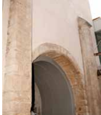
A 100 éve befalazott kapu megnyitásakor a bontással párhuzamosan építették ki a szerkezetet stabilizáló boltíves betonkeréget.
