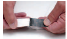
A hőolvasztásos hegesztés biztos vízzárást eredményez az illesztéseknél.
