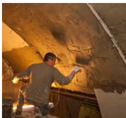
A MAPEGROUT TISSOTROPICO betonjavító habarcs felvitele a Rákóczi téren
