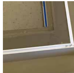
A medence körüli folyóka MAPELASTIC szigetelést kap
