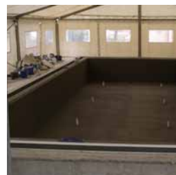
Medence kent szigeteléssel
