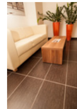
A gresburkolat kiépítésénél a KERAFLEX EASY ragasztóanyagot és a KERACOLOR FF FLEX fugóanyagot alkalmazták.
