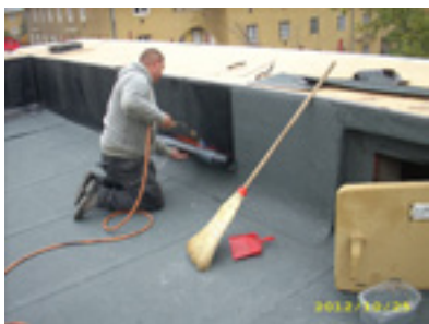
A függőleges felületeken a vízszigetelő rendszer első rétegét ADESO SPIDER P öntapadó lemezből készítették.
