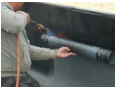
Az ADESO SPIDER P öntapadás vízszigetelőlemeze lángolvasztással rögzítették a PLANA P MINERAL 5 kg réteget.
