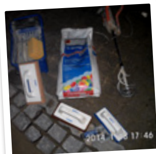
3 A fugázás előkészületei. MAPESTONE PFS 2, vízes edény, keverőszár, MapeiKék behúzó, tisztító szivacsok.
