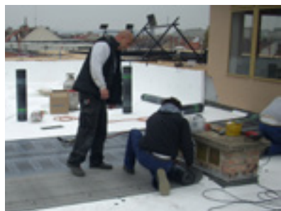
A PLANA P 3 mm fektetése a hőszigetelő rétegre.
