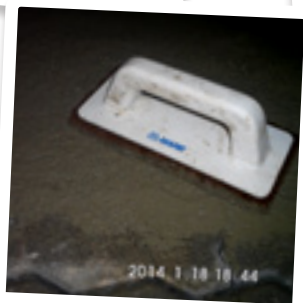
4. A fugaanyag Mapei lehúzóval könnyen bedolgozható
