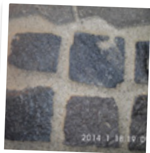
6. Mindkét kőről könnyedén eltávolítható a felesleges fugaanyag.
