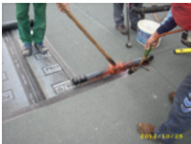
PLANA P MINERAL rögzítése lángolvasztással.
