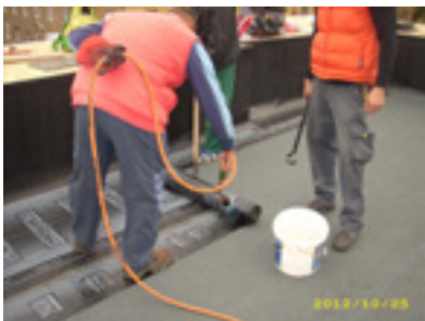
PLANA P rendszer – PLANA P 3 mm és PLANA P MINERAL 5 kg. A képen a második réteget rögzítik lángolvasztással.
