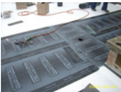
A polisztirol hőszigetelő táblákat, valamint a PLANA P 3 mm szigetelőlemezt teleszkópos csavarokkal, mechanikus megoldással rögzítették.
