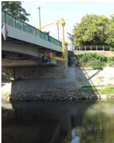
A Rowin Alpin Bt. referenciáiból: Rába kettős híd felújítása Győrben.
