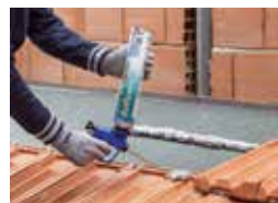
A MAPEPUR ROOF termékek hézagkitöltők, ragasztóhabok kézi és pisztolyos bedolgozással is bedolgozhatóak
