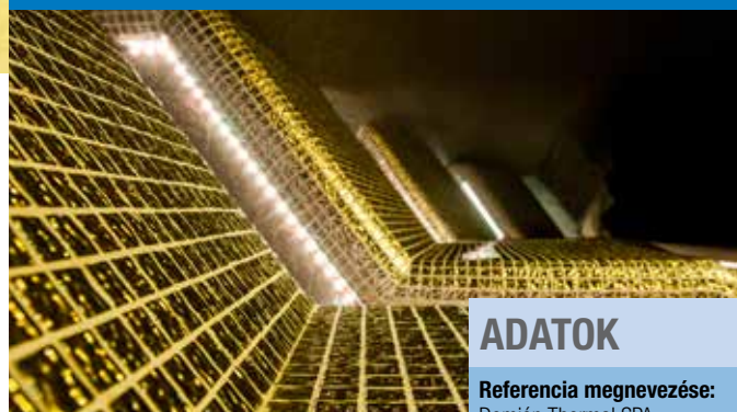
Az áttetsző üvegmozaik ideális ragasztójának bizonyult a fehér ELASTORAPID.
