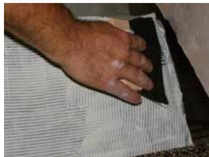
A MAPESONIC CR alá az ULTRABOND ECO V4 SP ragasztó felvitele ugyanúgy történik, mint a PVC burkolat fektetése során.
