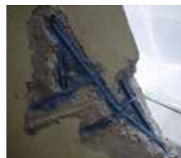
A MAPEFER 1K passzíválóval és a MAPEGROUT 430 betonjavító habarccsal biztonságosan javíthatunk vasbeton szerkezeteket, például erkélyeket, pilléreket.
