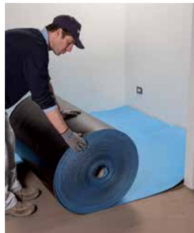
A hanghidak kialakulását MAPESILENT BAND-dal akadályozhatjuk meg.
