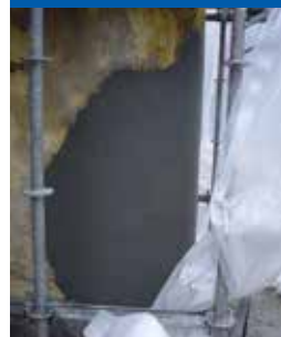
A MAPEFER 1K passzíválóval és a MAPEGROUT 430 betonjavító habarccsal biztonságosan javíthatunk vasbeton szerkezeteket, például erkélyeket, pilléreket.
