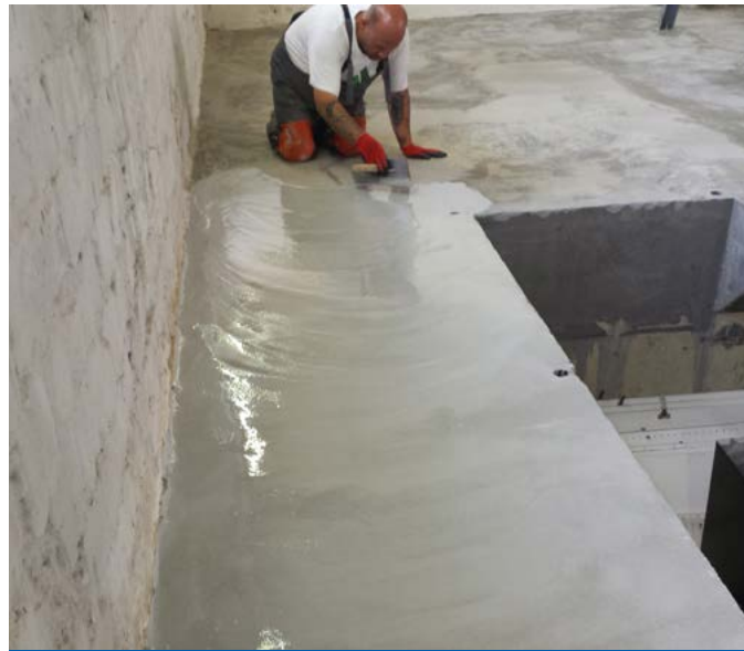
TRIBLOCK TMB felvitele szigetetlen aljzatra, annak felújítása során
