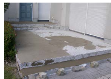
A bontás után a laza részekről és a szennyeződéstől megtisztított felületet egyenlítőjük ki PLANITOP FAST 330-cal
