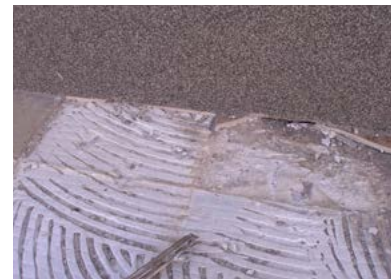
A régi burkolólapok eltávolítása után jól láthatóvá válnak a víz nyomai a burkolat alatti rétegekben
