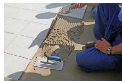
Ezt követően ragasszunk üregmentesen, szappanosodásra nem hajlamos ragasztóanyagot, például ELASTORAPID-dal, vagy GRANIRAPID-dal.
