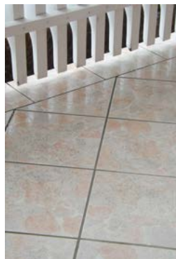
Még mindig az eredeti burkolat látszik, ami KERAFLEX-szel és ULTRACOLOR-ral készült
