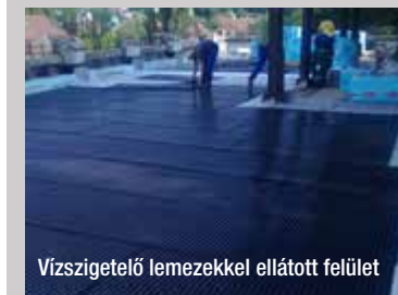
Hőszigetelő lemezek, elválasztóréteg és szivárgó réteg fektetése
