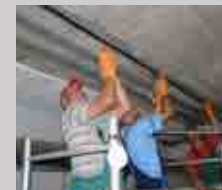
Vasbeton földem megerősítése CARBOPLATE lemezekkel
