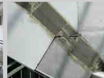
Előregyártott vasbeton szerkezet csatlakozásainak megerősítése CARBOPLATE lemez és MAPEWRAP szövet segítségével
