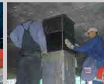
Pillér köpenyezése MAPEWRAP szövettel
