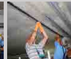
CARBOPLATE lemez felragasztása ADESILEX PG 1 ragasztóba
