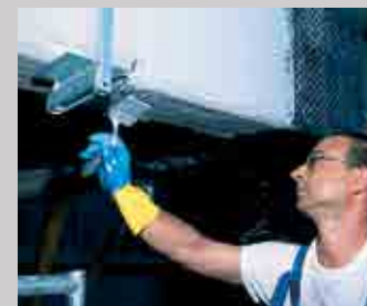
Alapfelület előkészítése MAPEWRAP állékony gyantával megerősítő szövet felhelyezése előtt
