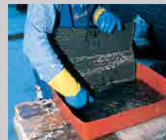
Szén szál szövet átítatása MAPEWRAP 21 folyós, kétkomponensű epoxi gyantával
