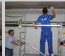
ADESILEX PG1 felvitele CARBOPLATE lemez ragasztáshoz
