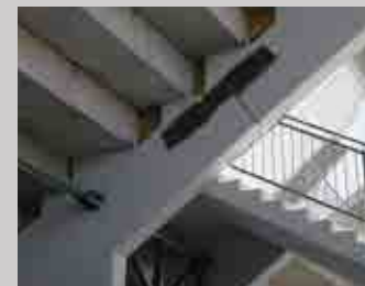
Előregyártott vasbeton szerkezet csatlakozásainak megerősítése CARBOPLATE lemez és MAPEWRAP szövet segítségével
